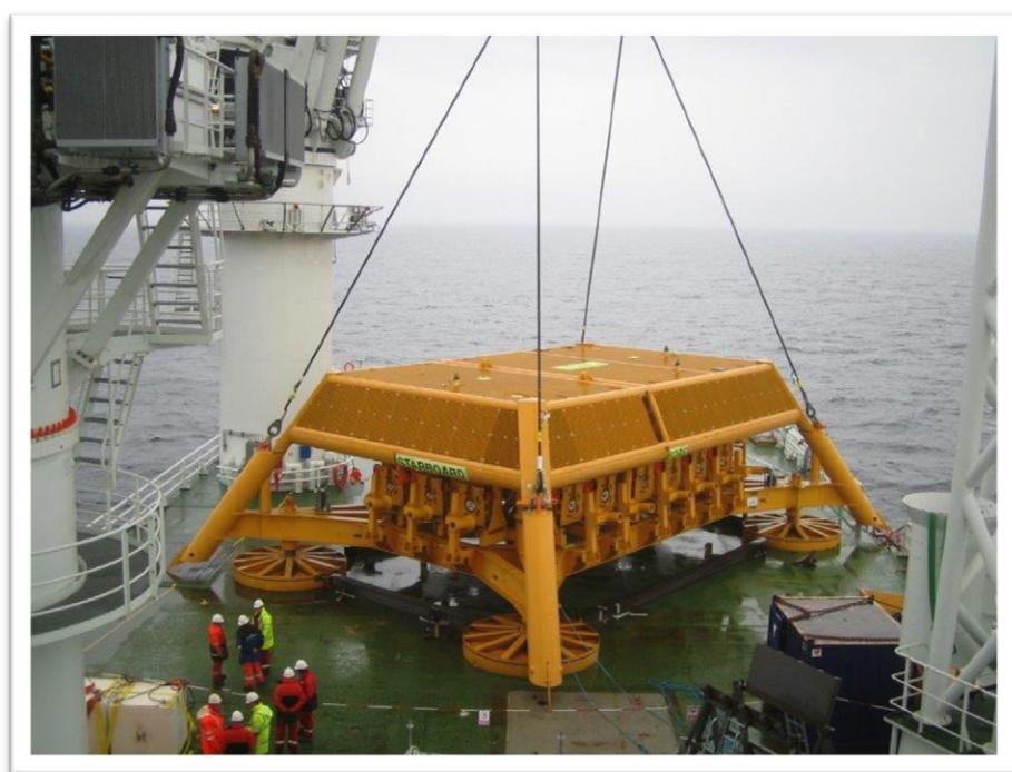
Figur 2-4. Yme manifoldstruktur
