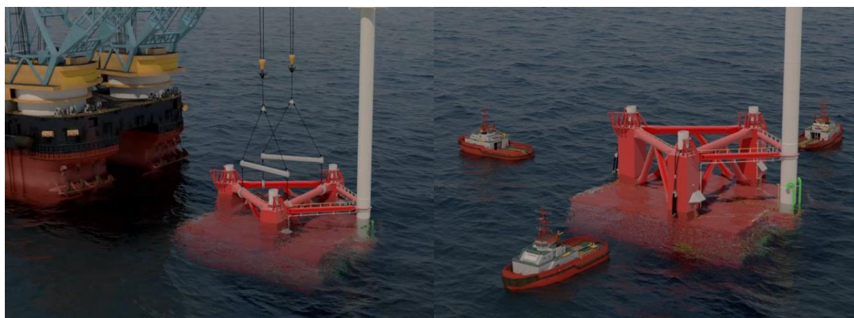
Figur 0-2. Skisser som viser hvordan hevingen av lagertanken kan foregå og deretter tauing til land.
