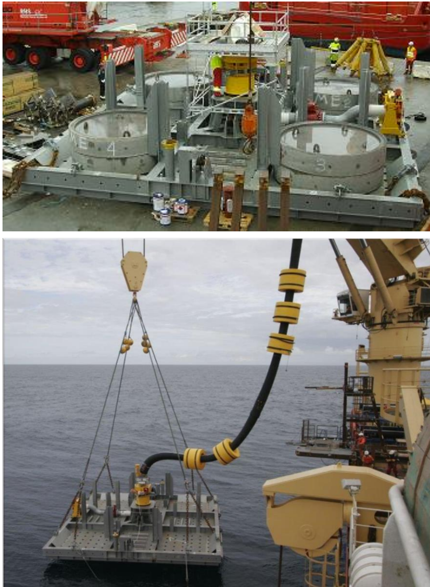
Figur 2-7. Lossesystemet på kai og ved installering offshore. Platen på det nederste bildet er utstyrt med fire betonglodd på sjøbunnen. Det fleksible røret fra basestrukturen og opp til skip for oljeeksport er utstyrt med flyteelement på deler av lengden.
