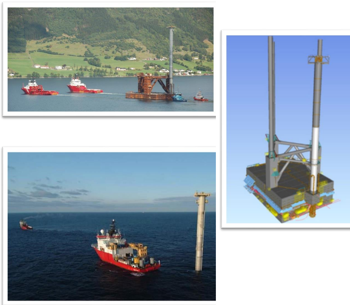
Figur 2-3. Yme lagertank under slep og installasjon på feltet (kun caissonen er synlig). Skisse av selve tankstrukturen med plattformbein og caisson er vist til høyre.
